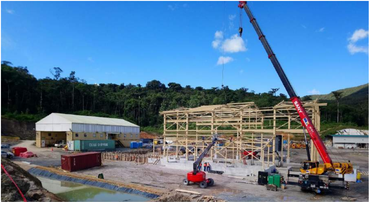
Figura 5. Construcción del taller de mantenimiento de la mina
