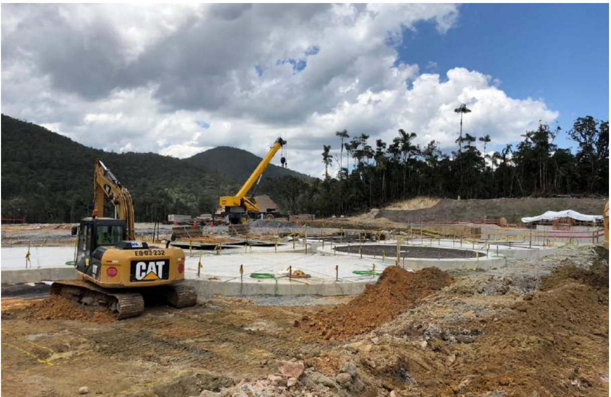
Figura 4. Cimientos de los tanques CIL
