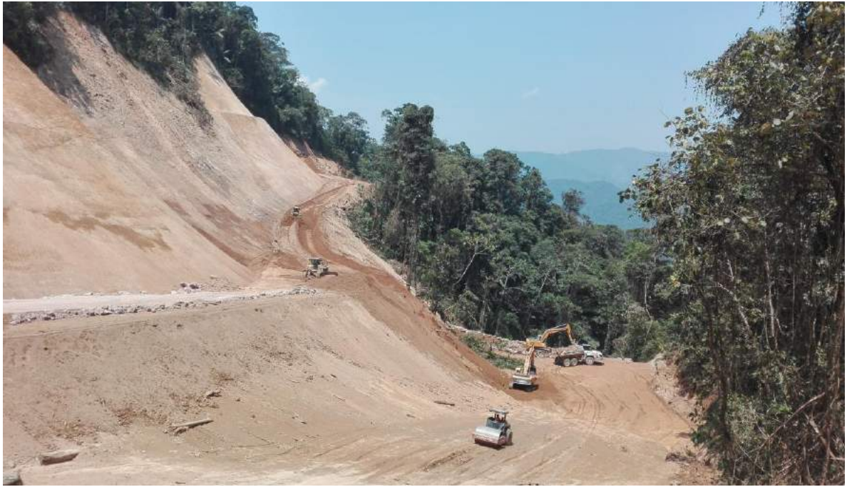
Figura 6. Se continúa con la construcción de la relavera
