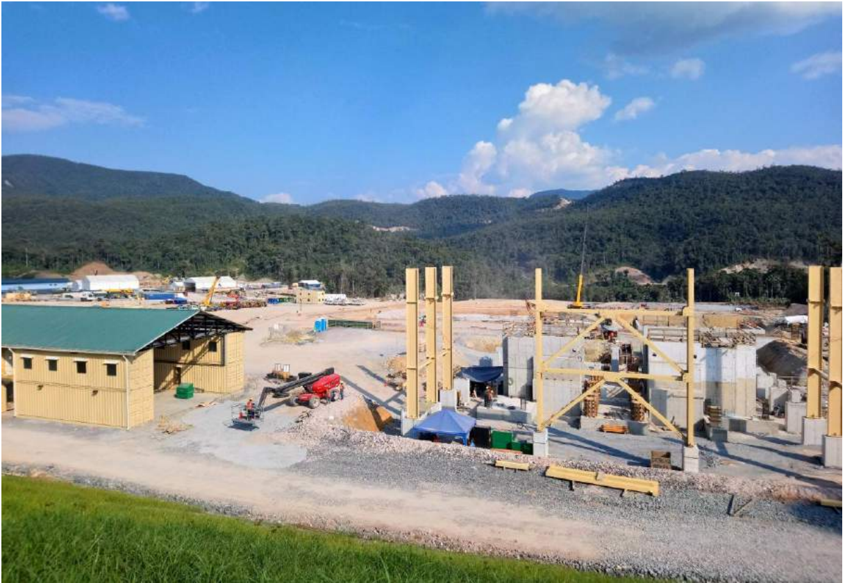
Figura 4. Cimientos de los tanques CIL
