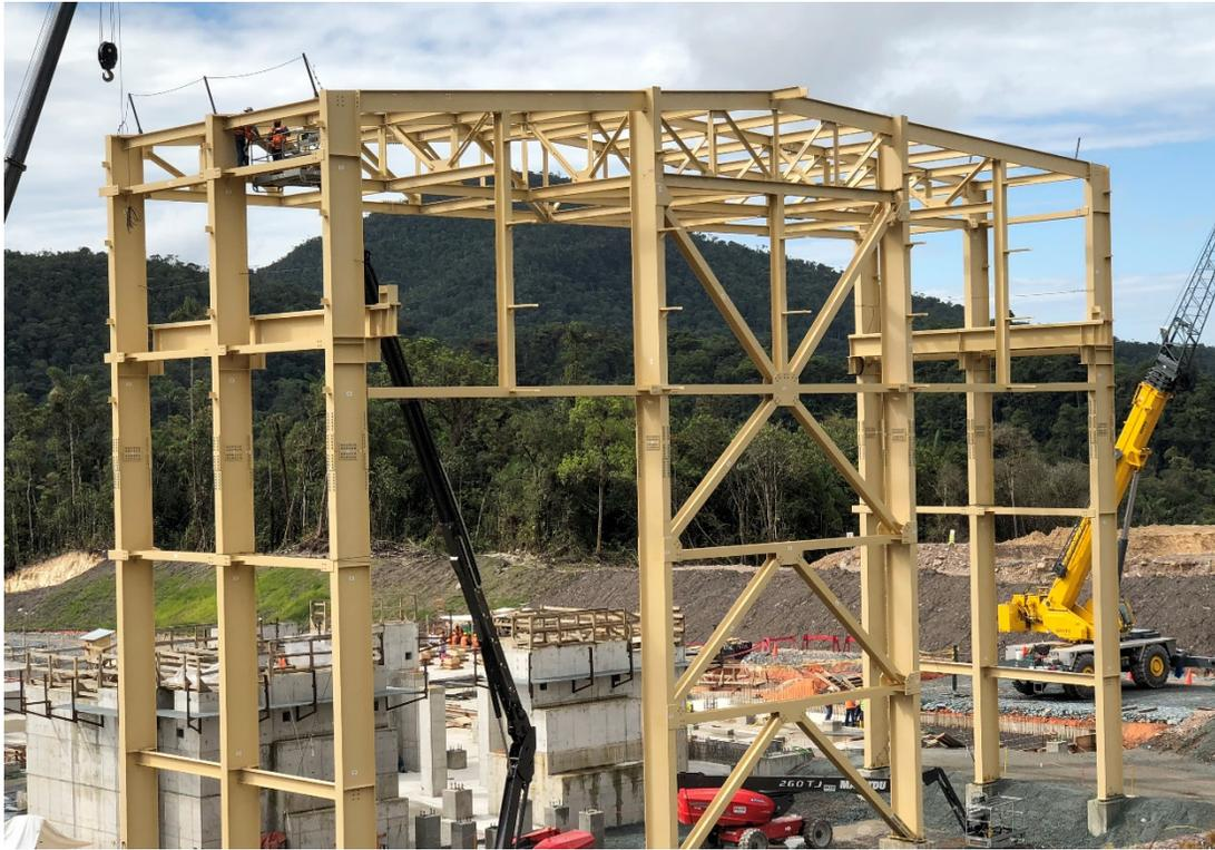
**Figura 4. El nuevo taller de mantenimiento permanente tendrá seis bahías.**
