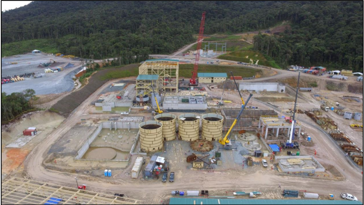
Figura 3. El concreto de la planta de procesos tiene un avance del 62% y el levantamiento del acero está en un 18%
